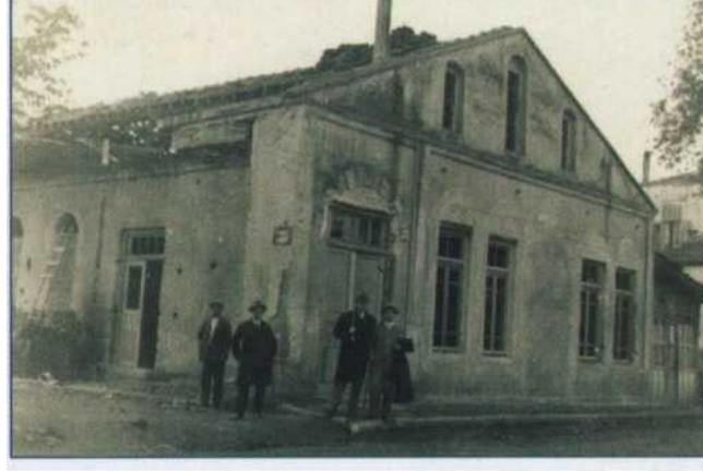
Resim 27 Işık Locası Binası Fotoğrafi
